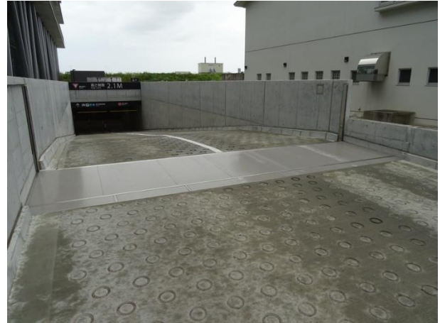
写真：地下駐車場入口にある起伏式防潮板
