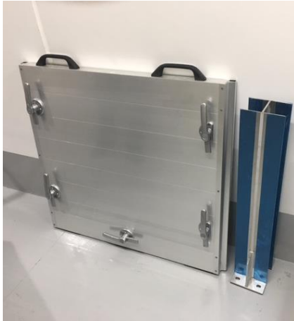
写真：倉庫に準備された脱着型防潮板
