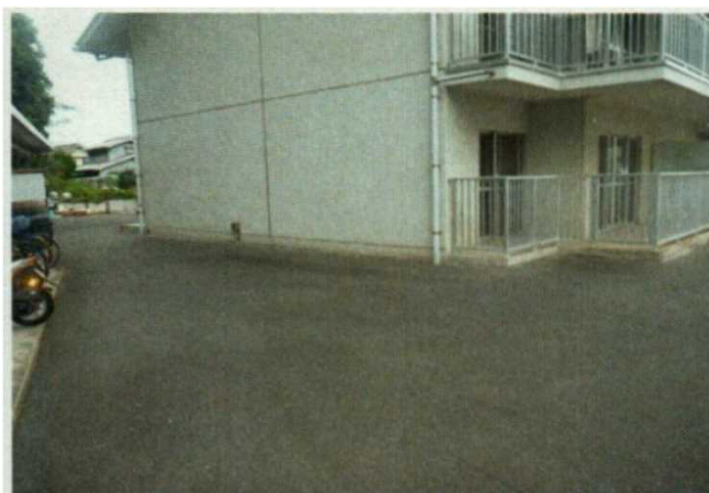
施工箇所② 施工前
