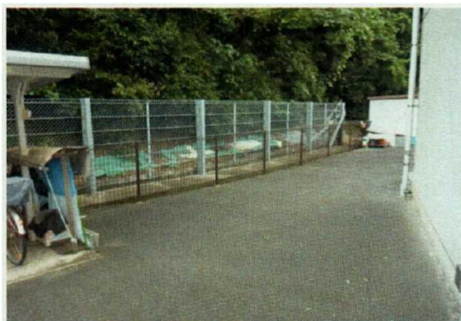
施工箇所① 施工前
