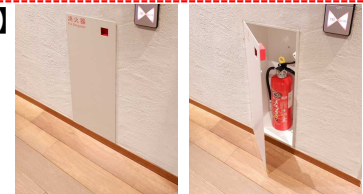
廊下上の壁埋込型消火器ボックス
