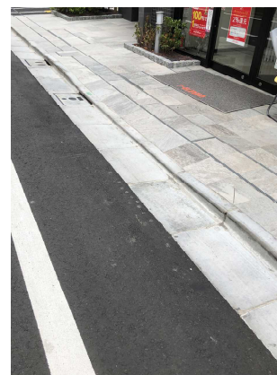
●L形側溝切り下げ 店舗出入口から道路側へ水勾配を 設け、L形側溝の切り下げを設置
