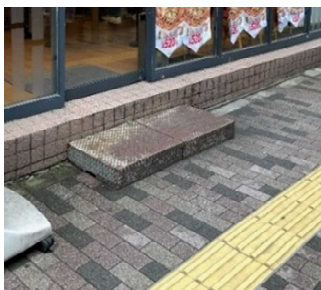
●踏み段を道路内に設置 段差のため、車椅子使用者 が入店困難であるうえ、踏 み段が、歩道上に設置させ ており、通行の障害となる。
