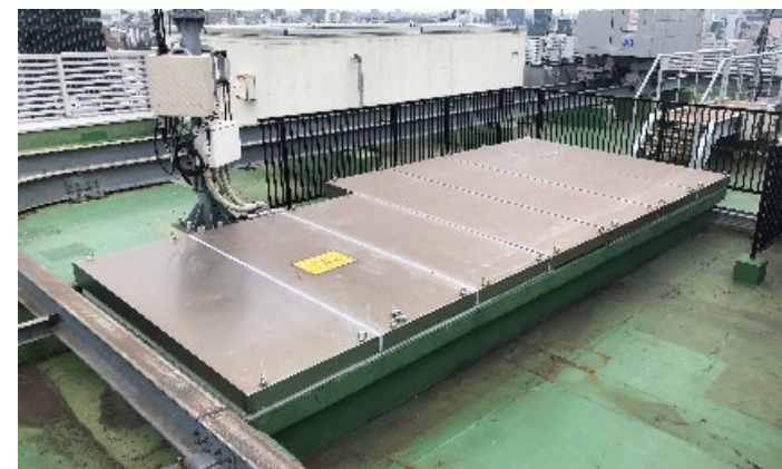
▲屋上マシンハッチ外観
