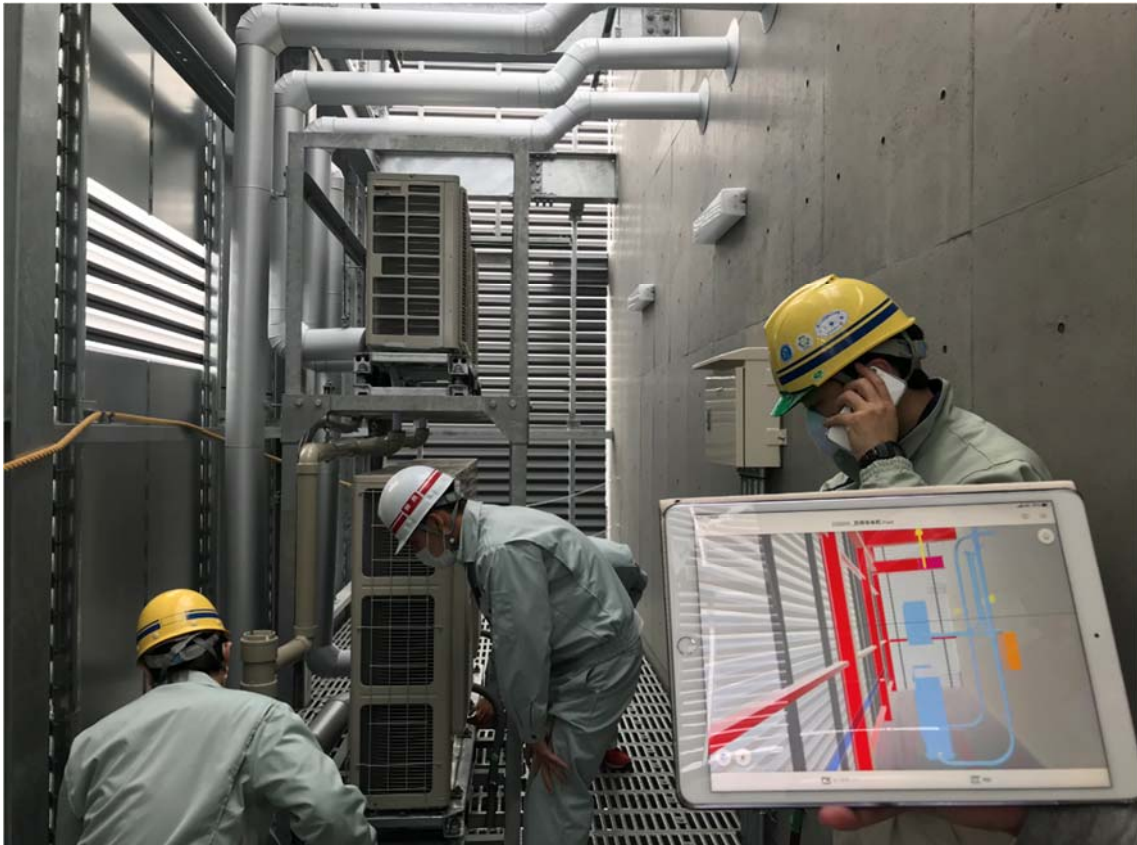
図 5-1 現地と維持管理 BIM の確認
