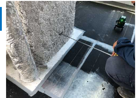
既存鉄骨測量(アナログ)
