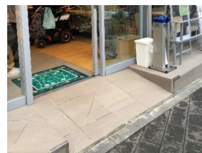
スロープの設置
