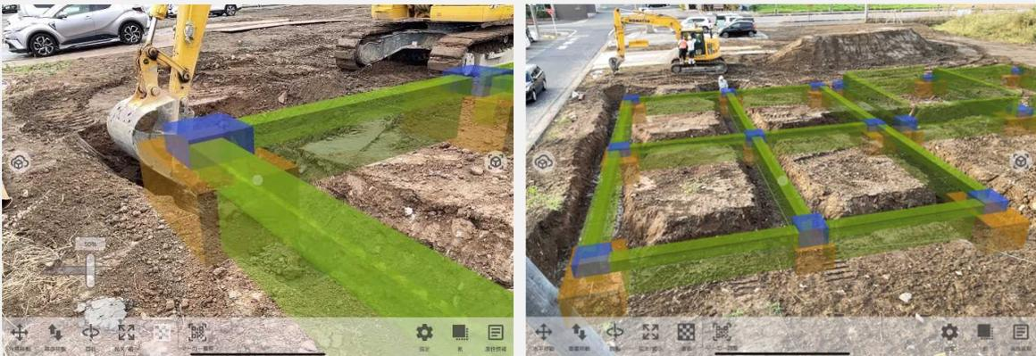
基礎工事におけるBIMを活用したICT建機による半自動掘削と基礎モデルのAR投影実験
