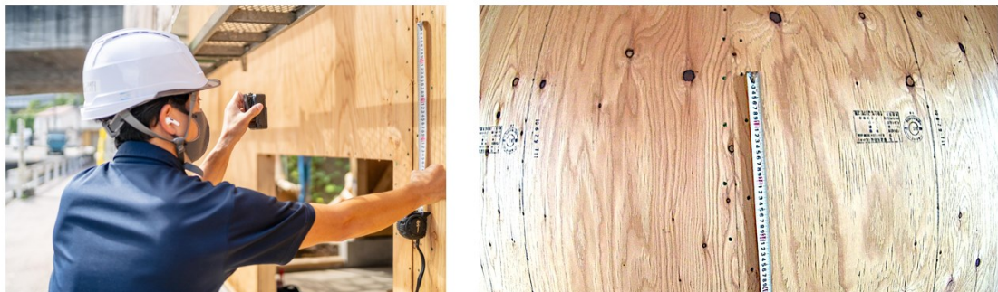
ウェアブルカメラでの釘ピッチ確認
