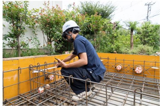
HMD 装着時と配筋検査時のイメージ
