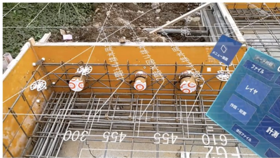
ヘッドマウントディスプレイ (HMD) による配筋検査及びスリーブ位置確認
