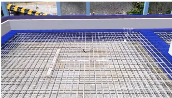
ヘッドマウントディスプレイ (HMD) による配筋検査及びスリーブ位置確認
