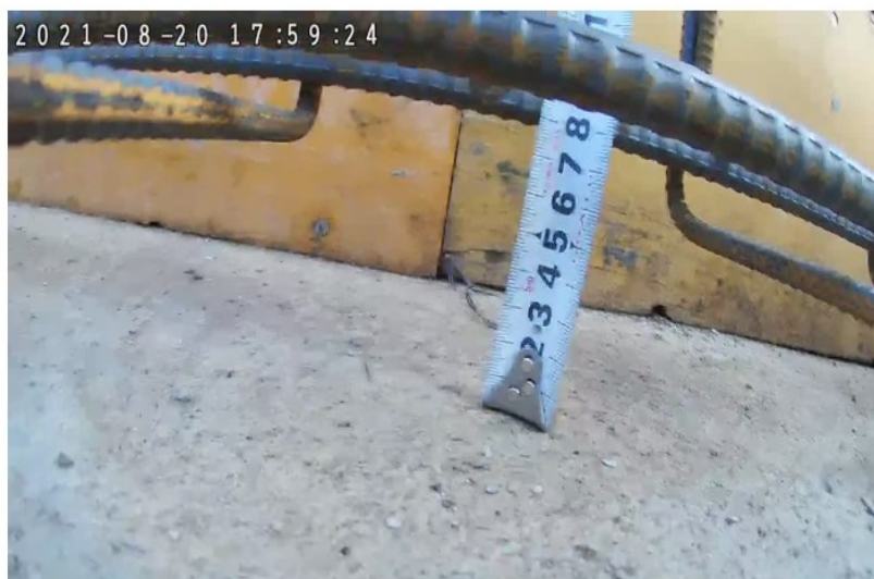
目視困難な箇所の確認
