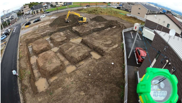
ICT掘削 10/13 二日目 10:00
