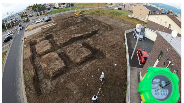
ICT掘削 10/12 一日目 1 6 : 0 0
