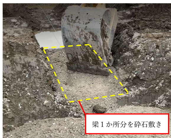
ICT 重機のオフセット機能を用いた碎石敷き込み実験
