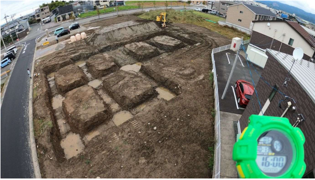
ICT掘削 10/13 二日目 16:00
