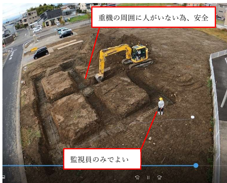
ICT 重機での半自動掘削状況
