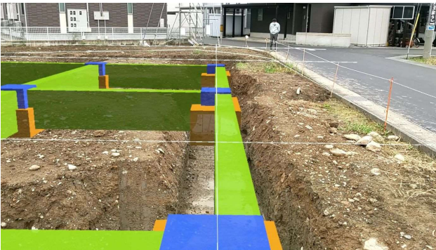
ICT掘削完了後 AR投影 周回確認 19
