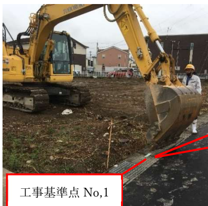
工事基準点に刃先を合わせ
