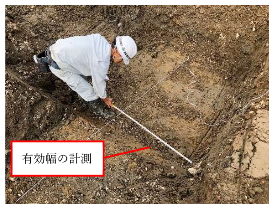
掘削出来形の計測状況
