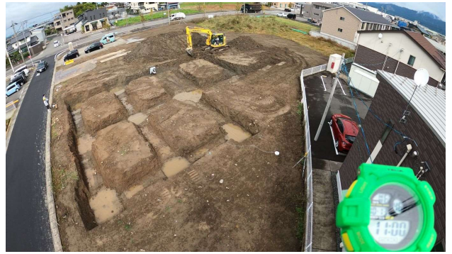
ICT掘削 10/13 二日目 11:00
