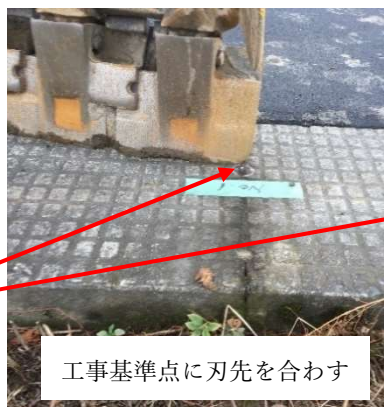
キャリブレーション状況 (バケット刃先位置の精度調整)
