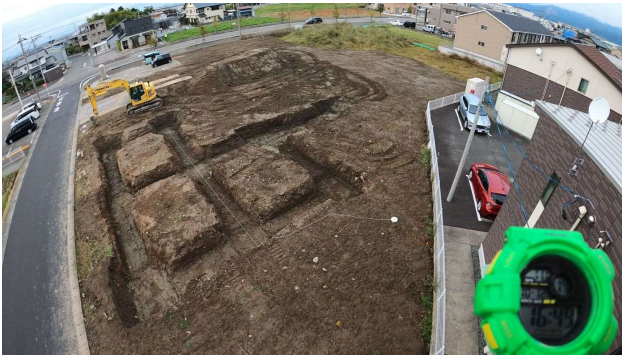
ICT掘削 10/12 一日目 16:49
