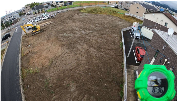
ICT掘削 10/12 一日目 8 : 3 6
