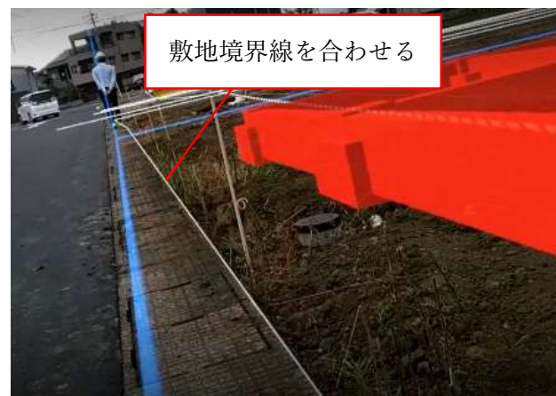
④ 敷地境界線を合わせ、投影角度の調整を行う。 AR マーカーを置く角度を微調整する。
