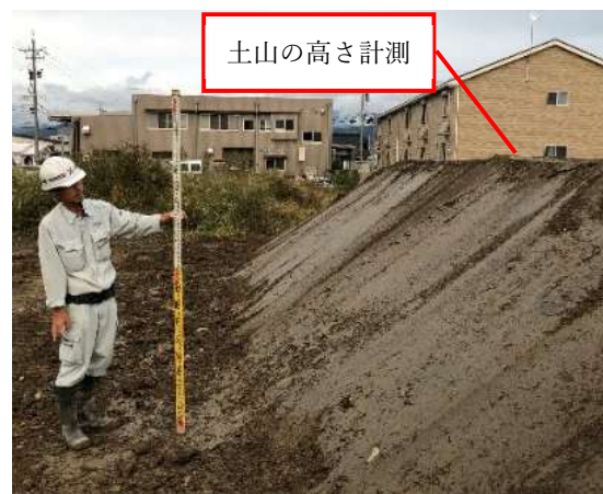
掘削発生土の計測状況
