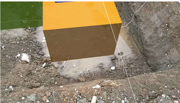
ICT掘削完了後 AR投影 周回確認 18
