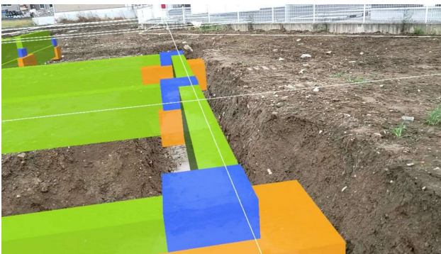
ICT掘削完了後 AR投影 周回確認 3
