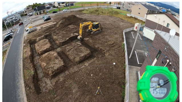
ICT掘削 10/12 一日目 1 5 : 0 0
