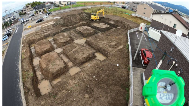
ICT掘削 10/13 二日目 12:00
