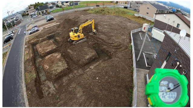
ICT掘削 10/12 一日目 1 2 : 0 0
