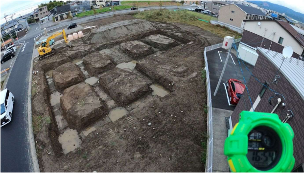
ICT掘削 10/13 二日目 16:54
