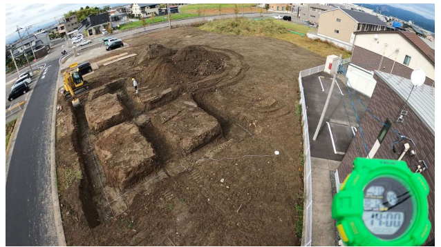
ICT掘削 10/12 一日目 1 4 : 0 0
