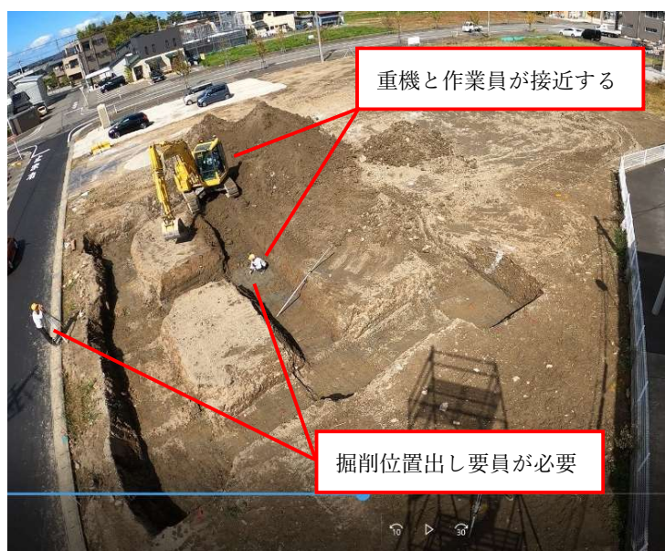
従来重機での掘削状況
