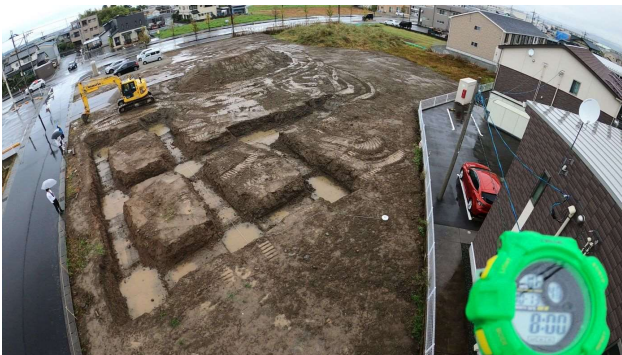
ICT掘削 10/13 二日目 8:00
