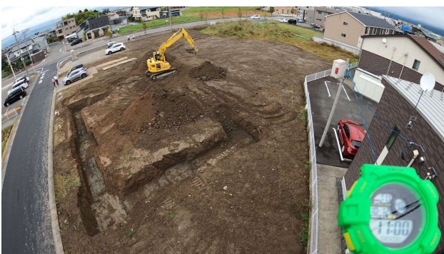
ICT掘削 10/12 一日目 1 1 : 0 0
