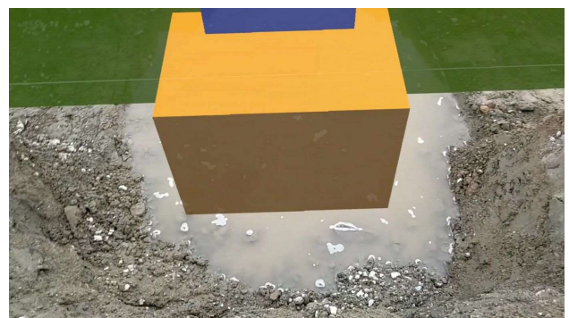
ICT掘削完了後 AR投影 周回確認 16
