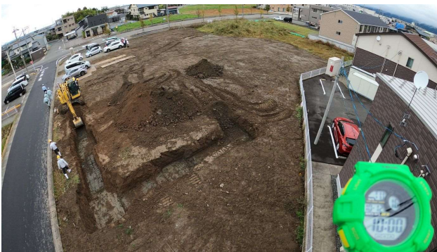
ICT掘削 10/12 一日目 1 0 : 0 0
