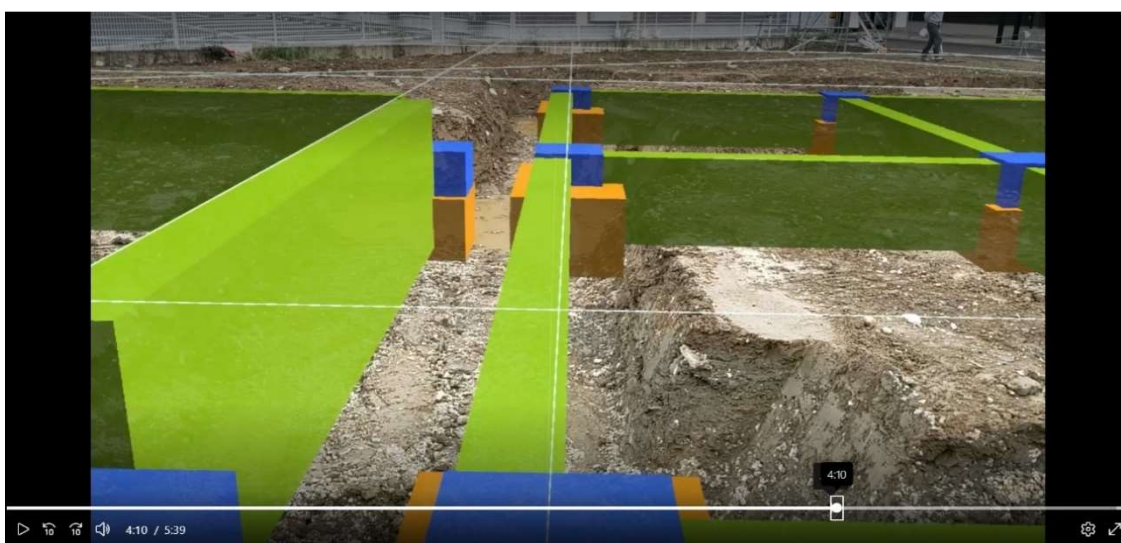
地中梁部掘削確認（ホロレンズ 2 使用）
