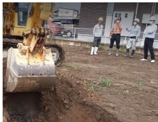
ICT 重機での掘削作業性の観察
