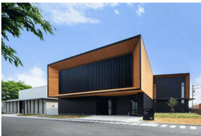
図 1-1-8 室内環境実験棟
