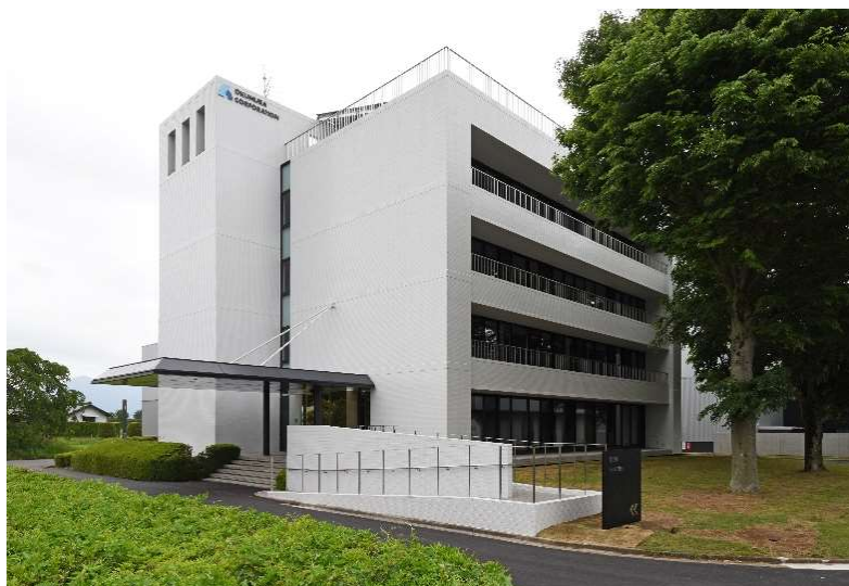
図 1-1-6 管理棟（リニューアル工事）
