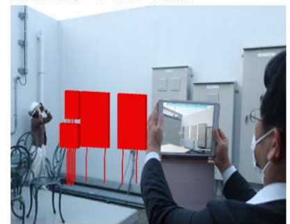
仮想空間による現地確認
