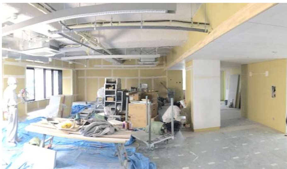
図 3-2-2 管理棟の改修工事
