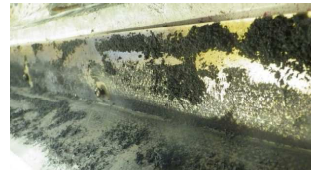
熱膨張による金物の浮き
