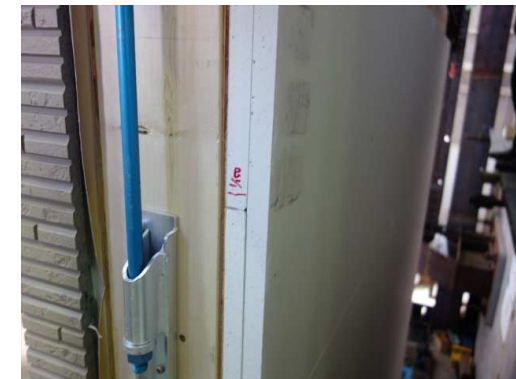
屋内側(非加力側)せっこうボード 微かな亀裂(右上の赤矢印)
