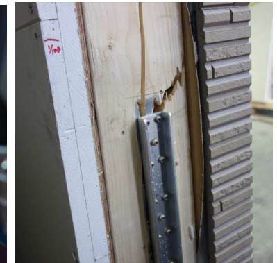
加力側脚部HDたて枠亀裂
