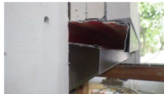
標準型水切り金物の通気層の加熱発泡材
