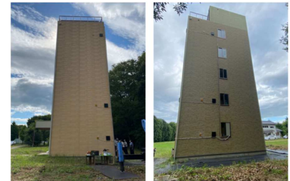
実験棟(左:東面、右:北面)
