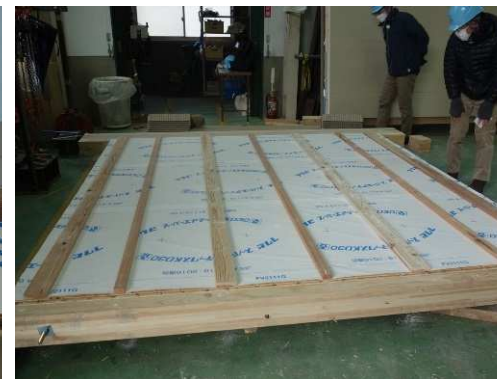
胴縁の状況 損傷なし 透湿防水シート 異常なし
