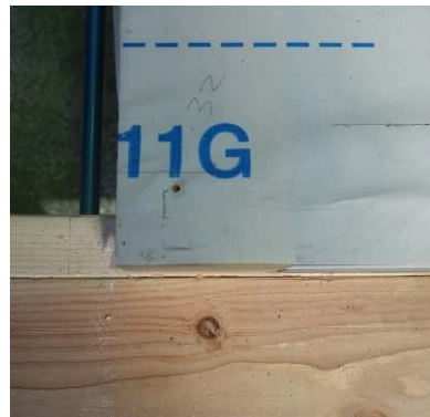
サイディング裏面 透湿防水シート 固定ステープル 異状なし
