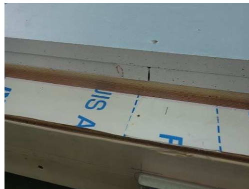
屋外側 強化せつこうボード端部 一部亀裂
