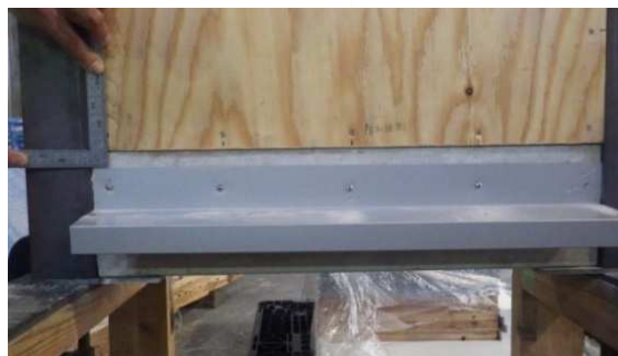
標準型水切り金物下側の設置状況
