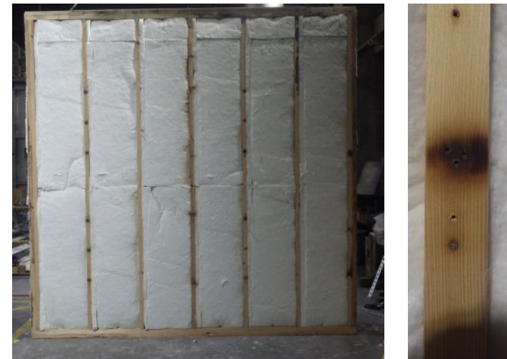
④試験体 試験後 木製下地
