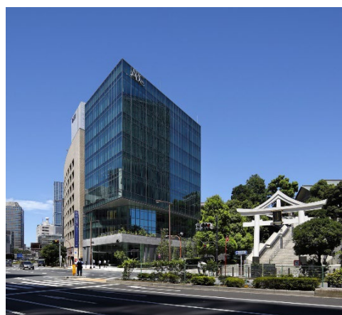
写真 1-1-1 : エービーシー商会本社ビル
