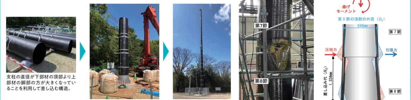
支柱の直径が下部材の頂部より上部材の脚部の方が大きくなっていることを利用して差し込む構造。
