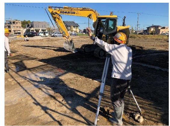
作業員が測量機器を使って掘削位置と深さを指示する。
