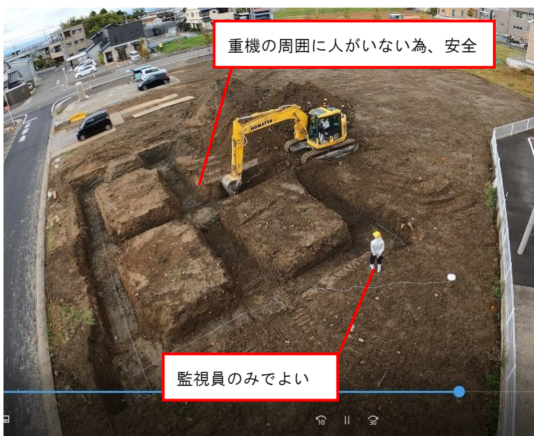
ICT建機での半自動掘削
