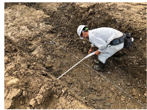
掘削完了後に実測確認
