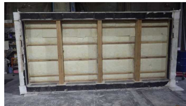
試験後の床組みの例 90-No.2 野縁のみ変色あり
