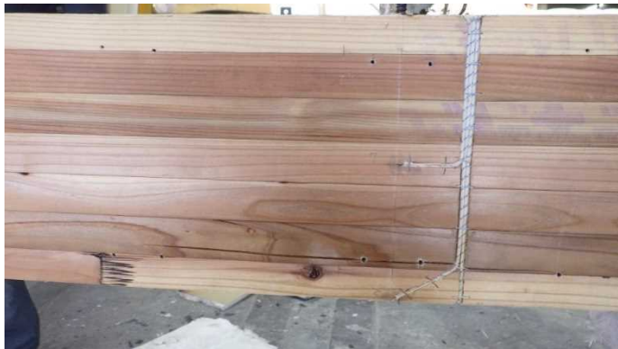
90-No.2 試験後 局所的な破壊の状況
