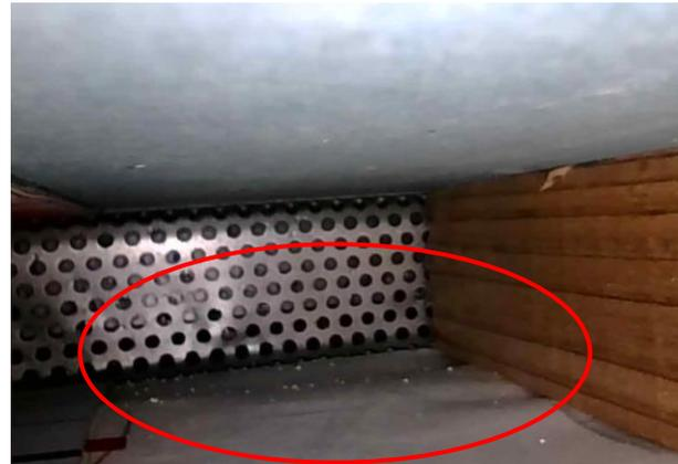
防虫網、透湿防水シートに付着した水滴 (写真②)
