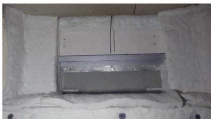
下部通気口 (炉内の設置状況)
