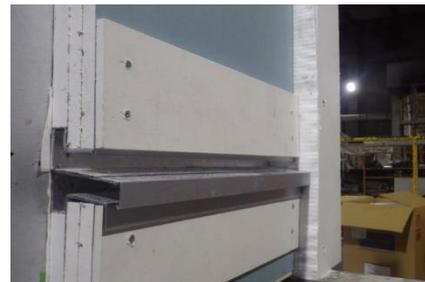
水切り・鋼製枠 (加熱膨張材)
