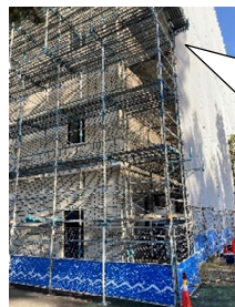
＜仮設足場の設置＞
