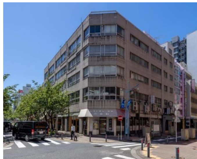
画像2: 対象既存建築物とした泰正ビル （戦災復興の象徴“防火帯建築”）
