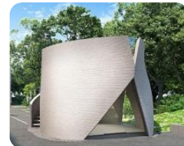
株式会社大林組 HPより
