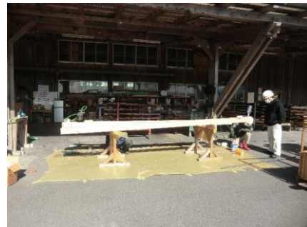
エポキシの充填(負圧注入) 鉄筋を挿入後、注入全長:4m
