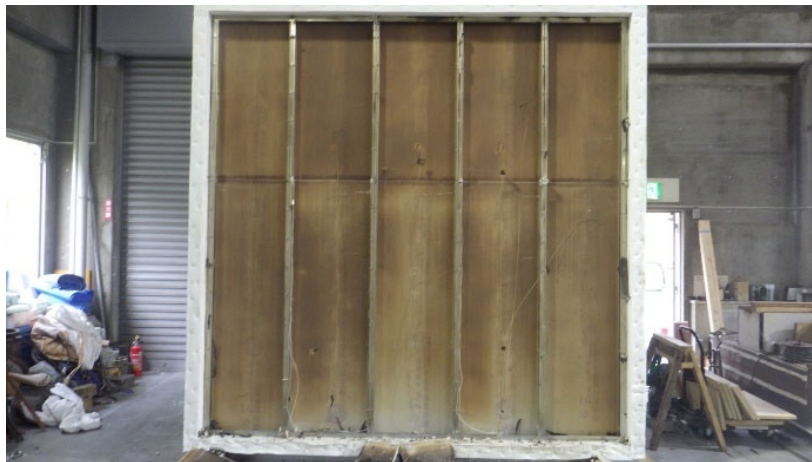
1.5時間：実験後試験体（壁内部）
