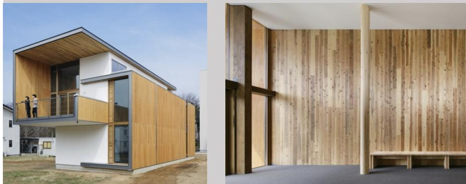
床CLT厚210mm/音源室：開放空間 h4.75m/受信室：4m×5m×h2.77m
