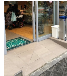
スロープの設置
