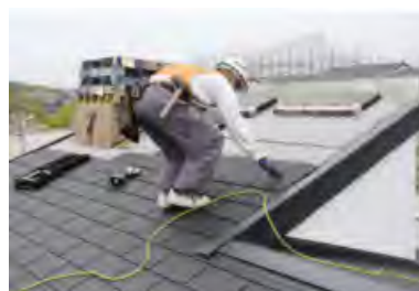
屋根の断熱化工事
