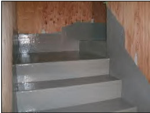
防水層及び層端部の立ち上げ
