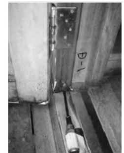
劣化調査用のファイバースコープ ドライバーによる触診 出典(左)：(株)関東エンジニアリングサービスHP https://kantoueng.co.jp/publics/index/29/ 出典(右)：(公財)日本木材保存協会HP http://www.mokuzaihozon.org/info/rekka/kensyu/index07.html
