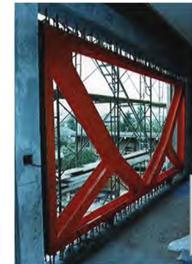
【補強】枠付き鉄骨ブレースを設置する工法の例
