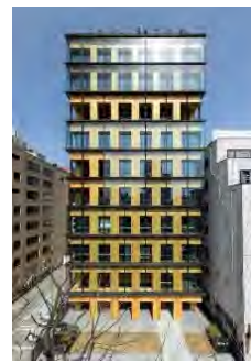
純木造 11階建て研修所
