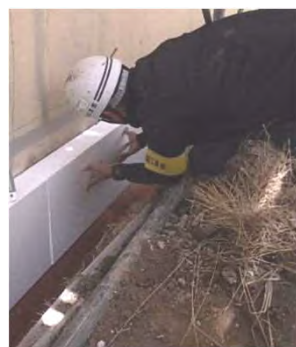
外壁の断熱化工事
