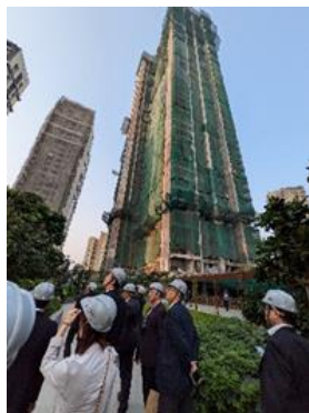
ルスタンジー視察 建設中の様子
