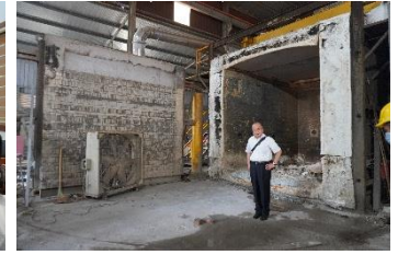
写真 1-2-3-ア University of Fire Prevention and Fighting (PCCC) 性能評価試験場
