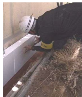
外壁の断熱化工事
