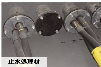
脱着型止水板
