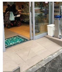
スロープの設置
