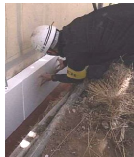
外壁の断熱化工事
