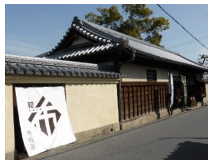
(例)歴史的建造物の修理・買取
