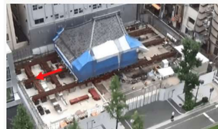
第2回曳家工事（2021年7月）
