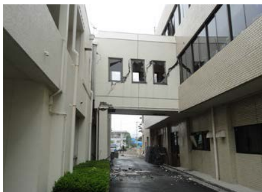
庁舎における構造部材の損傷
