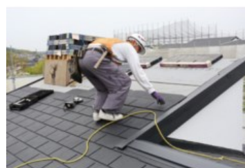
屋根の断熱化工事
