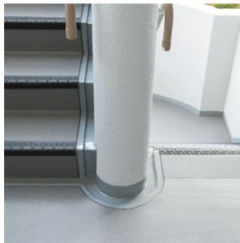
排水用の溝が設けられた段板及び踊り場
