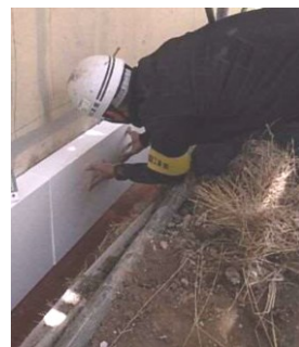
外壁の断熱化工事
