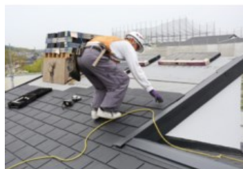
屋根の断熱化工事
