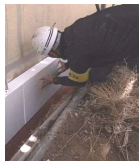
外壁の断熱化工事
