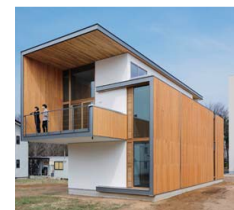
CLT（直交集成板）パネル CLT工法による実験棟
