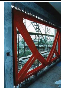
【補強】枠付き鉄骨ブレースを設置する工法の例
