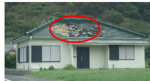
強風による屋根の被害(南房総市)
