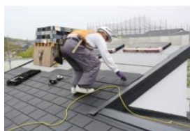
屋根の断熱化工事
