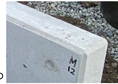
角部の面取り加工の例 (M12)
