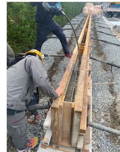
再生骨材コンクリートの施工状況の例(2025年度)
