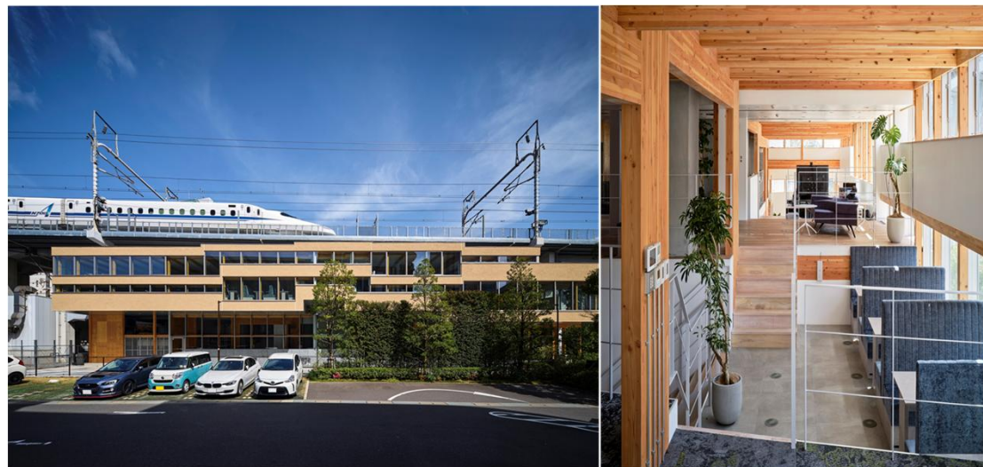
ささしま高架下オフィス 場所：愛知県名古屋市／構造：木造2階建て 横架材としてLIVELY WOODを使用している。
