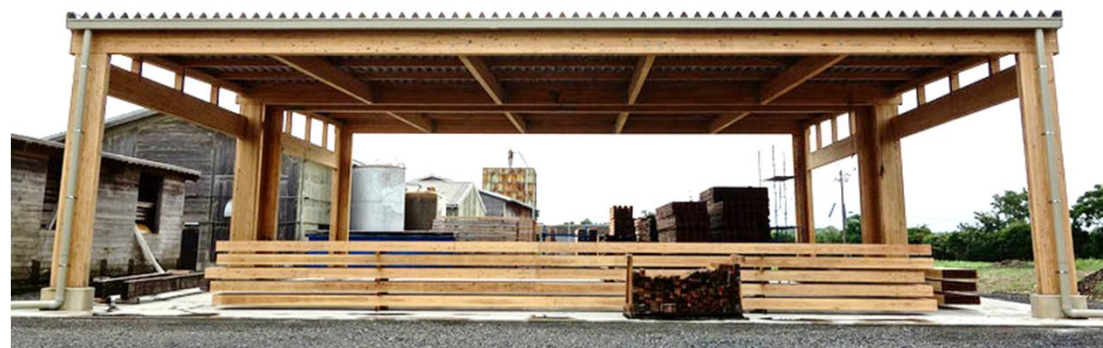
試作棟 場所：山佐木材工場内／構造：木造平家 横架材としてSAMURAIを使用している。
