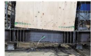
CLT-S梁接合面
