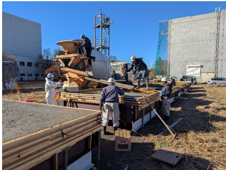
試験体コンクリート打設
