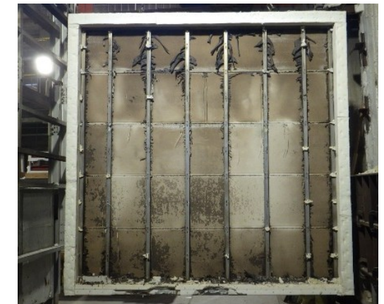
試験後 壁内部
