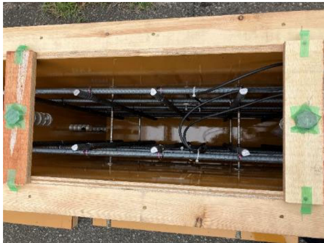
型枠外観と配筋状況
