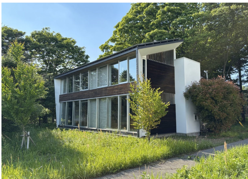
調査建物の南側外観
