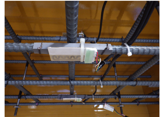
腐食センサの設置状況
