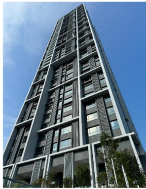
出典：三井不動産プレスリリース/2024.07 Mitsui Service Suite BCCの外観、室内イメージ
