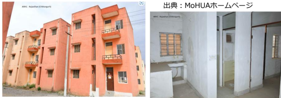
図：政府資金により供給された空き家の転用による公共賃貸住宅
