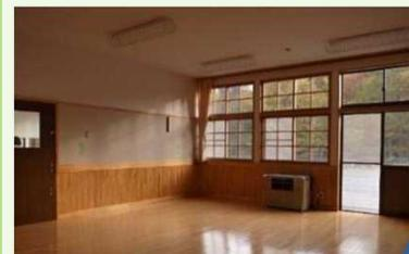
【従来】既存の木仕上げを撤去し、準不燃材料を新たに張る
