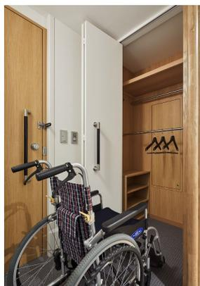
・金物を2カ所に設置し、床から高さ約120cmにハンガーパイプを移動できる収納
