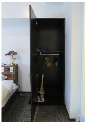
・ハンガーパイプを床から高さ約120cm・約90cmに移動することができる枕棚を設けた収納
