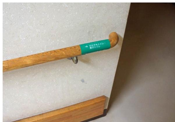
・JIS T 0921に基づいてレイアウト・製作された、手すりの点字表示
