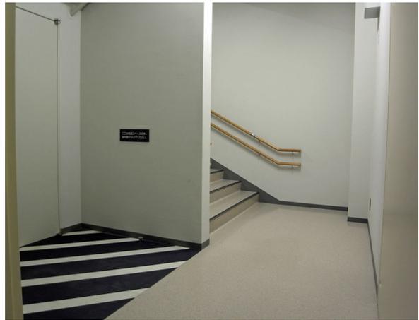
・緊急時に車椅子使用者等が落ち着いて安全に避難できるように、全階に直通する屋内階段に設けられた一時待避スペース（床面と壁面に一時待避スペースであることを表示している。）
