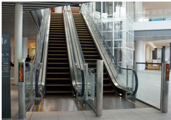
・エスカレーターの進行方向を表示した電光表示（進入禁止の表示があるエスカレーターに進入すると、ブザーが鳴る。）
