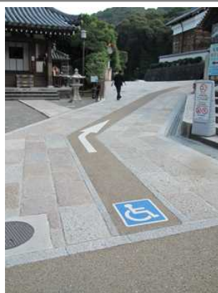
E 千体石仏群の前の車椅子用舗装部
