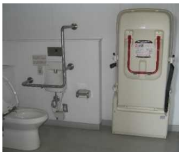
H 多機能便房 大型ベッドや乳幼児用ベッドを備えた多機能便房(計 24 カ所、うちオストメイト用設備を有する便房 12 カ所)を配置している。
