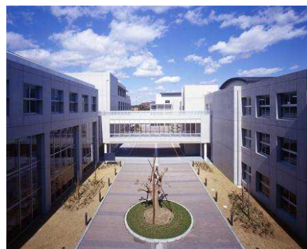
A 渡り廊下 雨天時に濡れることなく移動ができる様に各棟を渡り廊下で繋いでいる。
