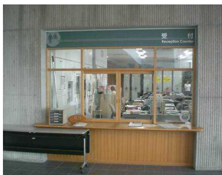
F 受付 車椅子利用者が利用しやすいように受付カウンターの高さを低くしている
