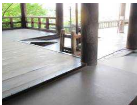
G 本堂に設けられたスロープ
