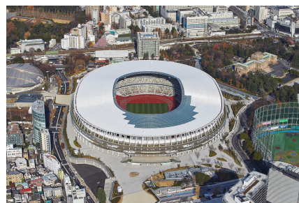
提供:独立行政法人日本スポーツ振興センター 施設外観
