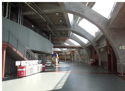
F 球場内を 1 周するコンコース(3 階) 平坦で十分な幅(内野 12m、外野 8m)のコンコース沿いに、飲食売店、多機能便房、車椅子使用者用観覧席等が設けられている。
