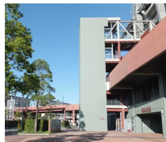
D 大型エレベーター 利用者アンケートに基づき、3階のコンコース・観覧席に至るエレベーター(26 人乗 高齢者・障害者優先)を 2014 年に増築した。
