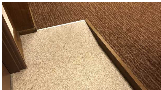
控室(本堂)の傾斜路
