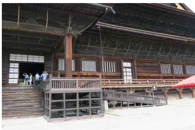
B 本堂東側スロープ
