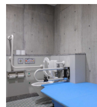
多目的車椅子 トイレ(多機能便 房)
