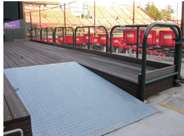
・ 改修により、内野席に設けられた車椅子使用者用観覧席 (サイトライン確保のため床面を嵩上げしている)
