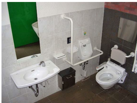
B 多機能便房 (男女共用)内部 手すり、手洗い水洗、オストメイト用汚物流し、大型ベッド、子ども用椅子を整備し、車椅子回転用のスペースを確保している。
