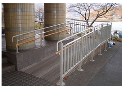
玄関前の手すり付きスロープ
