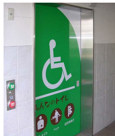
A 車椅子使用者等用便房入口ドア 内部に配置されている設備のピクトグラムをデザインした、自動式引戸になっている。
