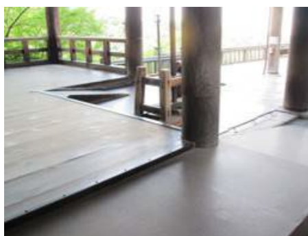
G 本堂に設けられたスロープ
