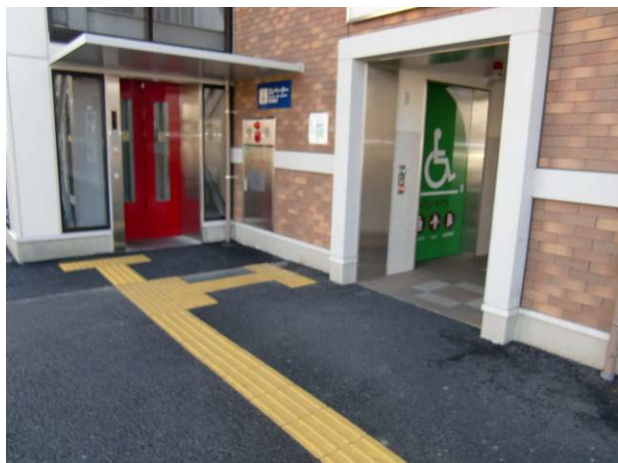
D 視覚障害者誘導用ブロック
