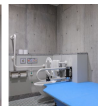
多目的車椅子 トイレ(多機能便房)
