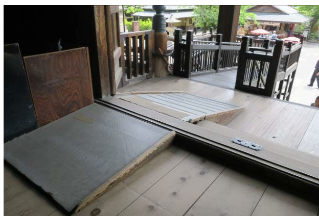
C 本堂に設けられたスロープ
