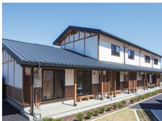
災害公営住宅の例（岩手県大槌町）
