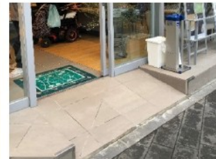
スロープの設置
