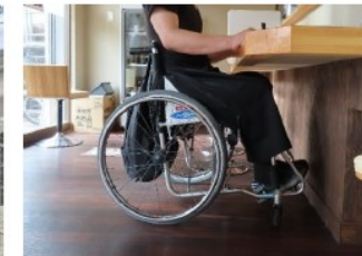
ローカウンターの設置
