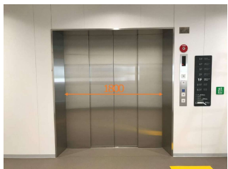
エレベーターの整備
