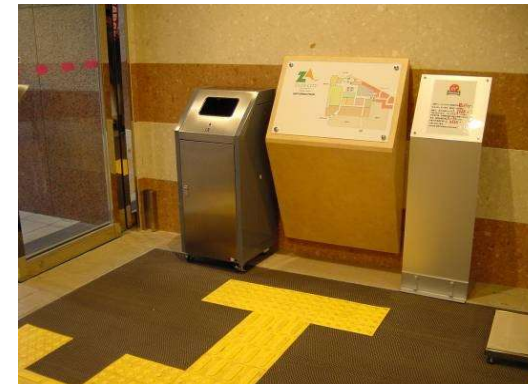
点字ブロック、点字案内板の設置
