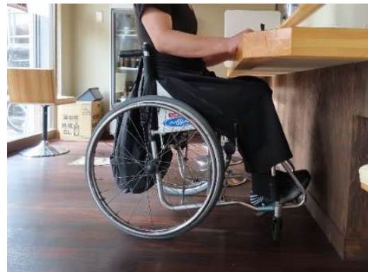
ローカウンターの設置
