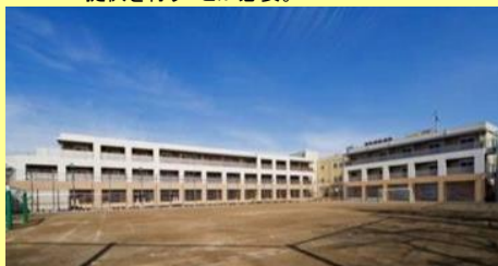
学校を改修して整備した事例
