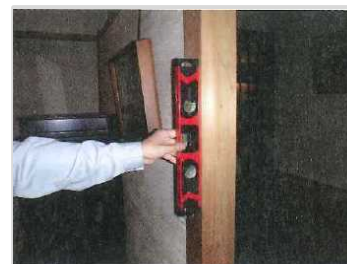
水平器による柱の傾きの計測
