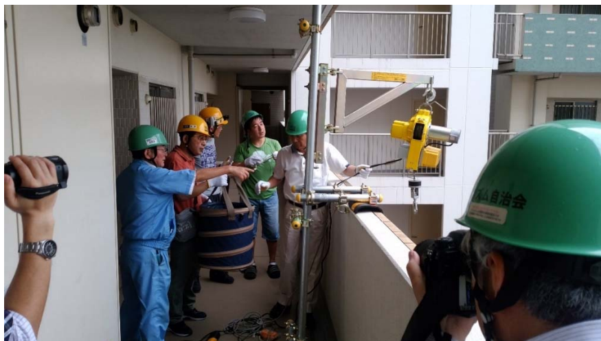
揚重システム 単管、アングル、ジャッキ等を組み合わせる
