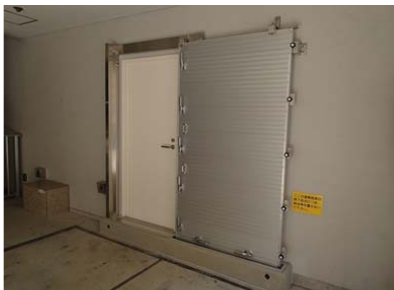
防水扉設置状況
