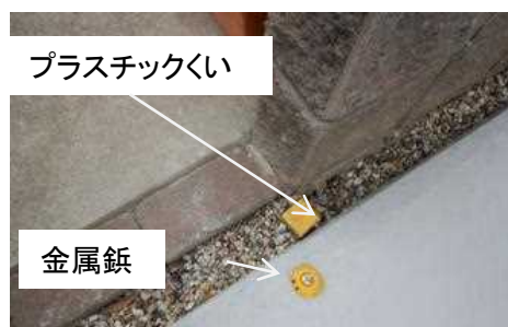
後退杭の設置
