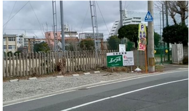
写真⑥ 市内の老朽危険家屋の解体後
