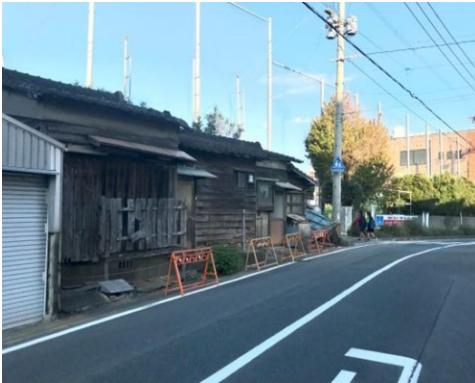
写真⑤ 市内の老朽危険家屋
