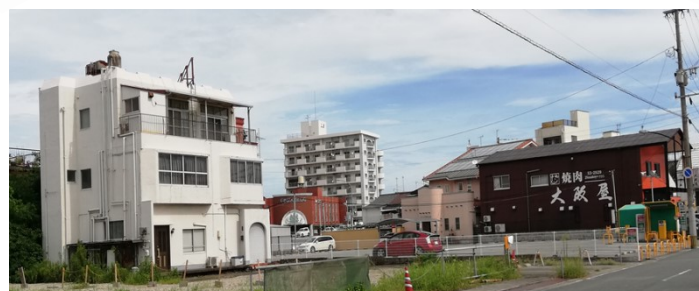
写真⑨ 市内の老朽危険家屋 解体後
