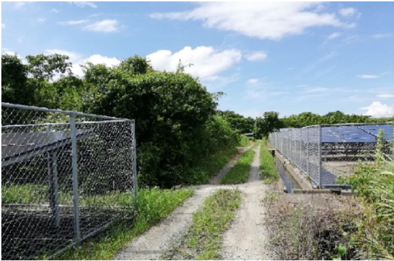
写真⑩ 市内の空き地（市街化区域内の雑種地）
