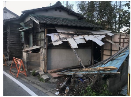
写真④ 市内の老朽危険家屋
