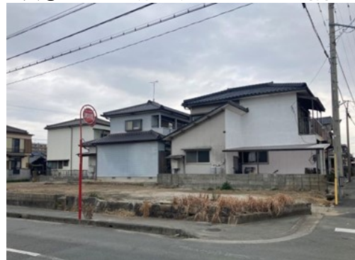
写真⑲ 2つの隣りあった空き家（解体後）
