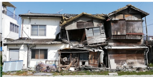
写真⑦ 市内の老朽危険家屋
