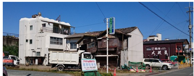
写真⑧ 市内の老朽危険家屋
