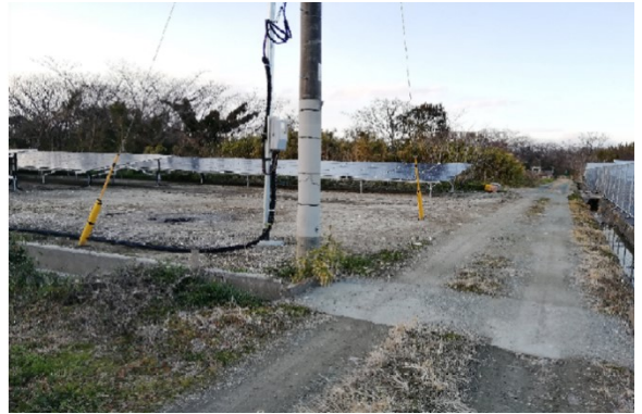
写真⑪ 太陽光発電用地（工事中）
